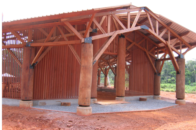
Poteaux en Tali (diamètre 0,6 m, longueur 8,5 m), charpente en Kosipo, bardage à claire-voie en Mukulungu – Réalisation J.Y. Riaux, Mindourou (Cameroun)
